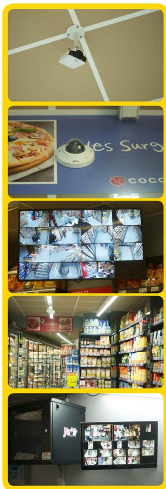
Pour une meilleure visualisation des vidéos et un affichage en direct des caméras au niveau des caisses, l'unité de visualisation VS240HD, permet aux employés de visualiser, en temps réel, sur un écran 46 pouces tous les mouvements en haute définition. Des écrans de 24 pouces sont aussi posés devant les accès principaux et au niveau du passage. La solution est ondulée pour prévenir d'une éventuelle
